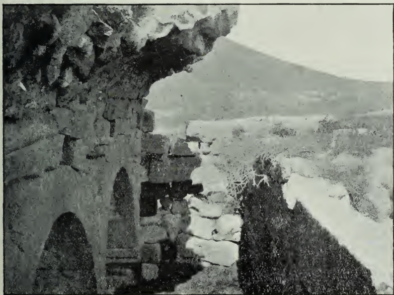
FIG. 108.—No. 16, S. aisle, looking E.
